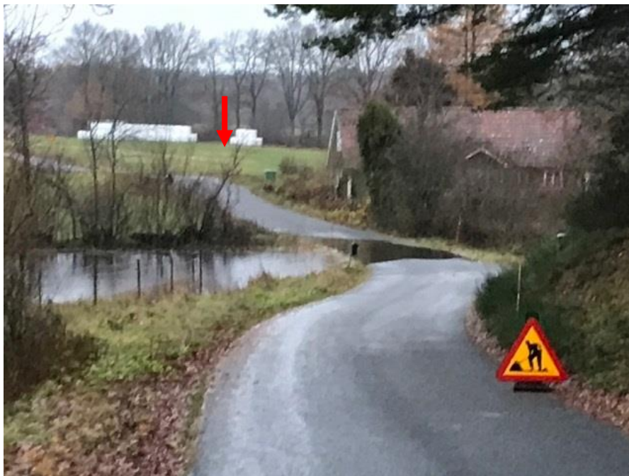
Bild 5. Översvämning 17 november. Röd pil är platsen för beviljat bygglov
