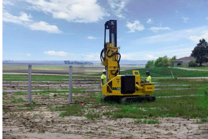
Figur 4. Exempel på pålningsmaskin på larvfötter för installation av pålar för stängsel och markställningar.
