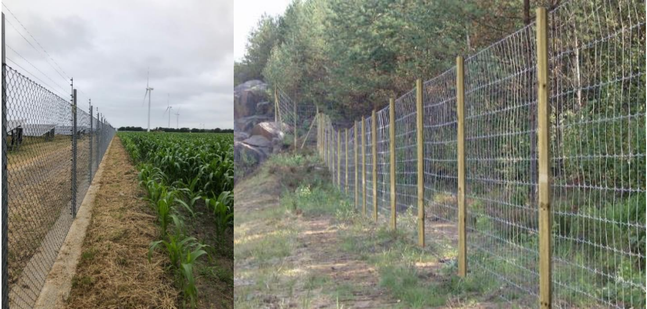
Figur 2. Exempel på utförande av industristängsel med invändigt överklättringsskydd i form av eltrådar (vänster). Exempel på viltstängsel på trästolpar och utan överklättringsskydd (höger).
